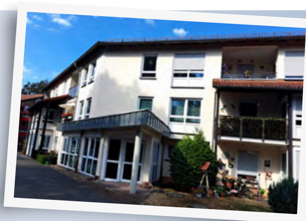
Der vom Bundesumweltministerium geförderte Fensteraustausch an der Seniorenresidenz am Erlenteich ermöglicht dem DRK in Alsfeld, Energiekosten einzusparen.
